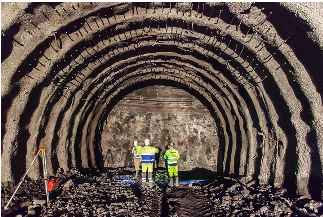
Mynd 6.3. Styrkingar setbergslaga í Norðfjarðargöngum í apríl 2014.
